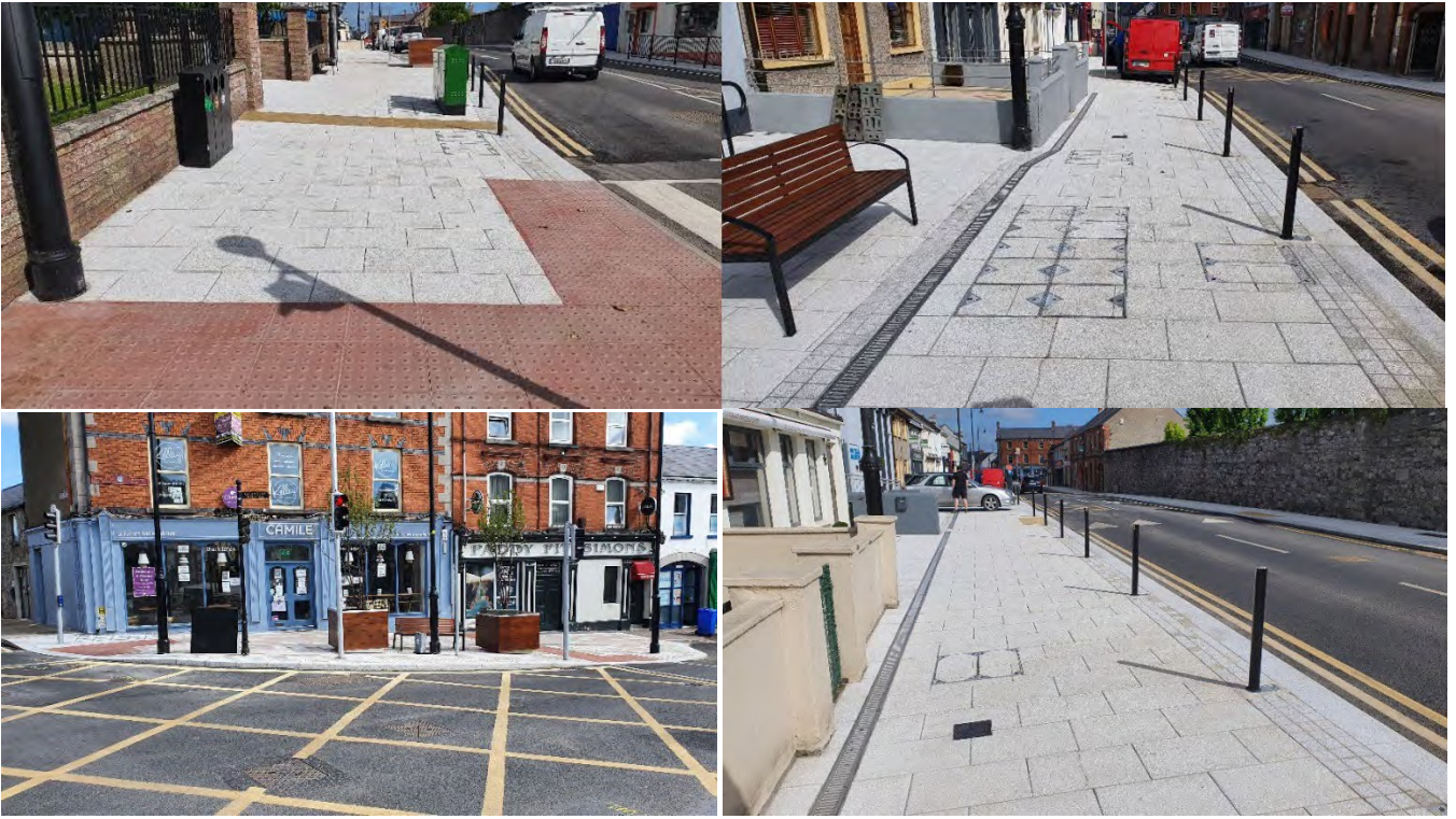
Oibreacha Críochnaithe ar Shráid an Iarnróid
