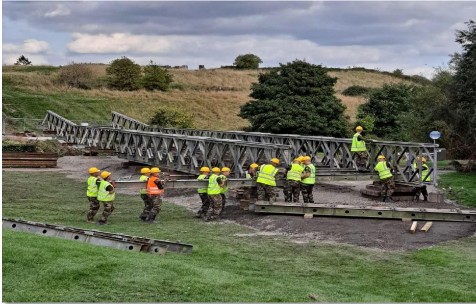
Droichead bábhúin sealadach sa phictiúr á shuiteáil i mBaile Átha Troim
